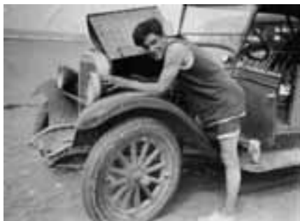
Héctor (Tito) y el Chevrolet Champion 1928 (motor 4 cilindros en línea con válvulas a la cabeza y llantas de madera).
