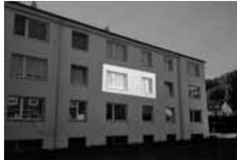
La Residencia por detrás. Las ventanas marcadas corresponden al apartamento ocupado por mis padres (Stockach, 1983-1987).
