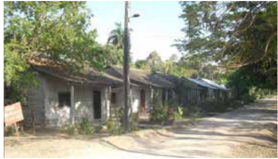
Casas de los obreros.
